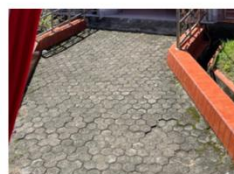
Gambar 7. Ramp dengan Paving Block Tidak Rata
