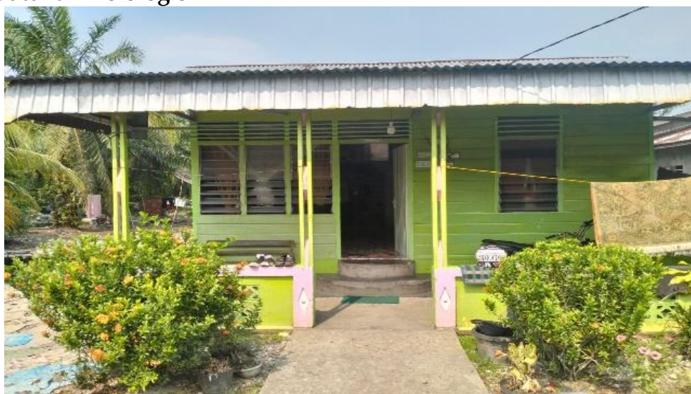
Gambar 5. 1 Keadaan Rumah Nelayan Sumber: Dokumentasi Lapangan 2025
